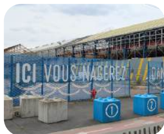
Visite du chantier de la future piscine, 17/04/2025
